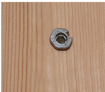
Karmen är som standard försedd med fabriksmonterade karmhylsor.
