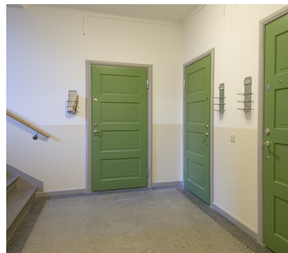
Säkerhetsdörrar typ D43 i renoverat trapphus
